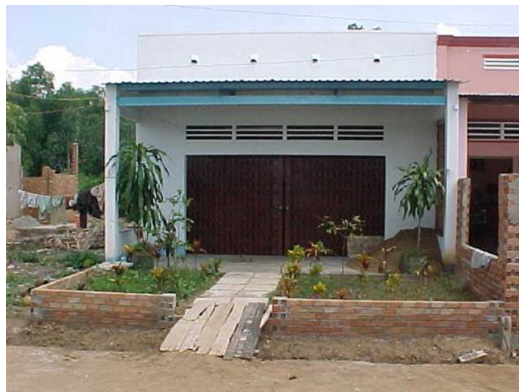
Unité type sur le projet de relogement Binh Trung Dong
