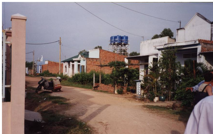
Vue d'ensemble du projet de relogement Binh Trung Dong
