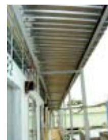
Couloir et toit rallongé
