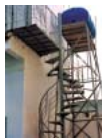
Escalier de secours
