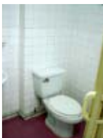
Toilettes foyer A.
